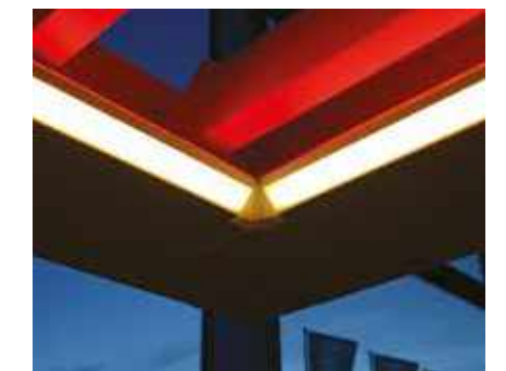
Die Regenrinne kann auch mit einer direkten und/oder indirekten LED-Beleuchtung erweitert werden
